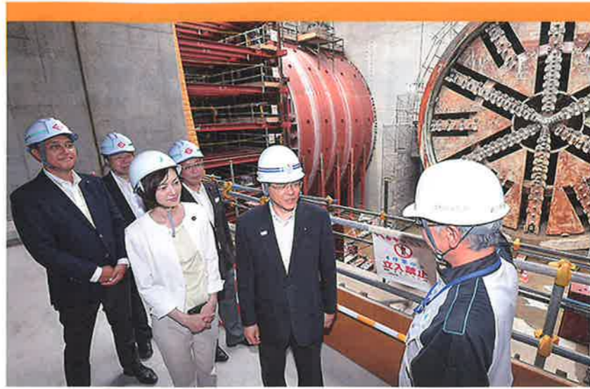
横浜環状北西線の建設現場
