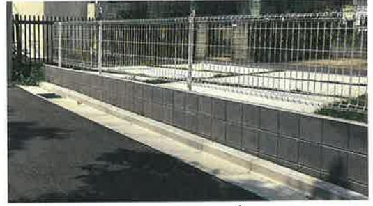
[新設フェンス]
