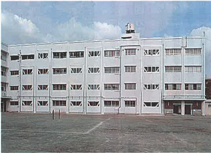
耐震化工事が完了した中学校校舎
